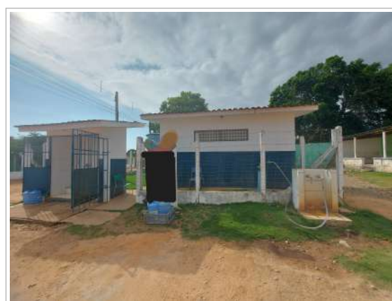
Figura 3 – Estação de Tratamento
